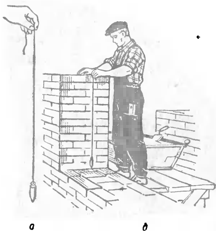
Рис. 34. а — Отвес. б — Каменщик проверяет вертикальность стены отвесом.
